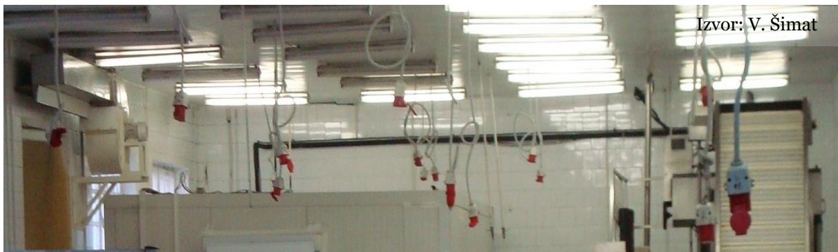
Slika 3.5. Viseći stropovi omogućavaju spuštanje svjetla i okomito spuštanje priključnih cijevi u prostoriju za preradu.
