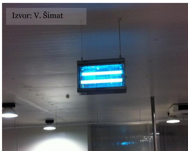
Slika 10.1. Primjer elektroničkog uređaja s UV lampom za usmrćivanje letećih insekata koji se koristi za veće prostorije (lijevo). Krupni plan elektroničkog UV uređaja za uništavanje insekata pokazuje zbog čega je redoviti pregled i čišćenje od iznimne važnosti (desno).
