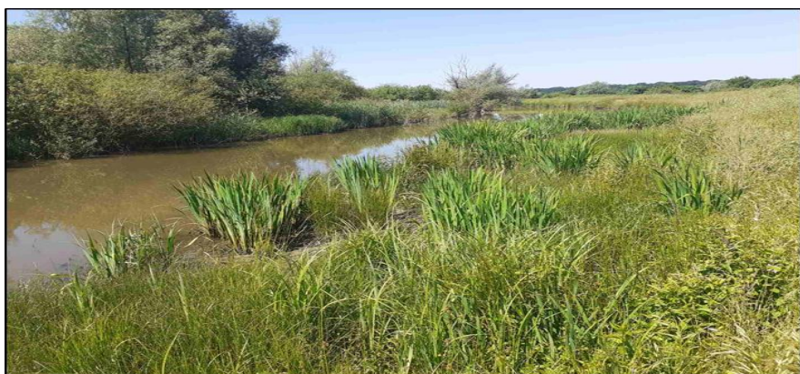
Prikaz stvarnog stanja lateralnog kanala Vagovina
