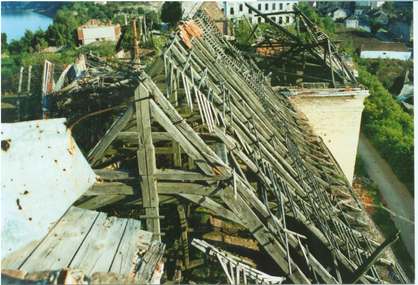
DETALJ BAROKNOG, HRASTOVOG KROVIŠTA IZNAD STAROG DIJELA LAĐE
