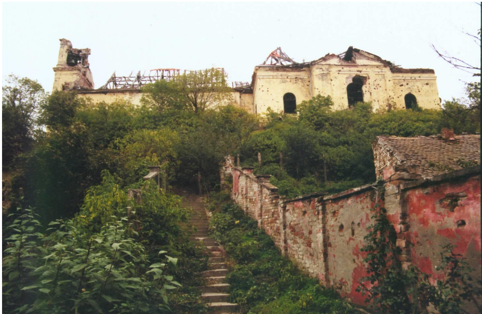
POGLED NA JUŽNO PROČELJE CRKVE PRIJE RADOVA – 1997. GOD.
